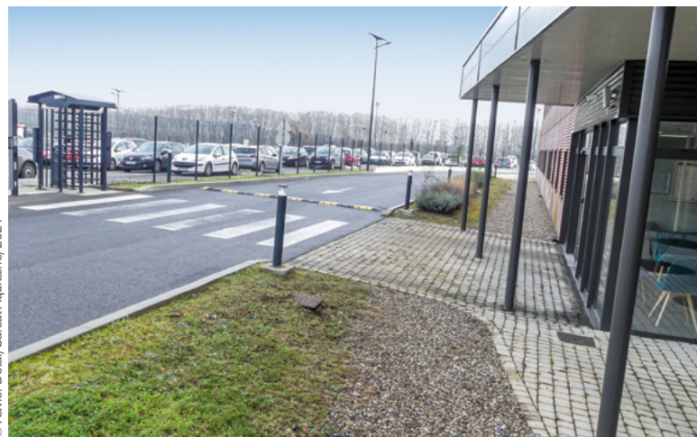
Photo 4.1 – Écarteur de circulation au droit d'un débouché de porte.
