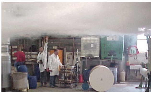
Figure 1.4 Ventilation par déplacement mise en place dans un atelier industriel
