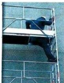
Accès à l'étage supérieur sécurisé
