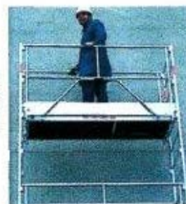
Mise en place des garde-corps La fixation des garde-corps est impérative pour passer à l'étape suivante. L'ordre de montage est bien défini.
