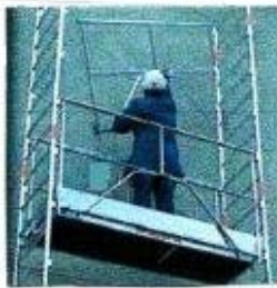
Mise en place des garde-corps La fixation des garde-corps est impérative pour passer à l'étape suivante. L'ordre de montage est bien défini.
