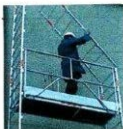
Mise en place des échelles
